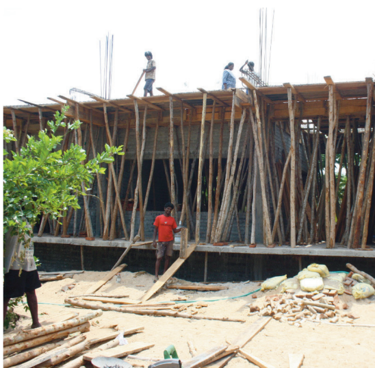
Die Bauarbeiten am Palk Bay Center wurden fortgesetzt und die Erweiterungsbauten schreiten schnell voran.
