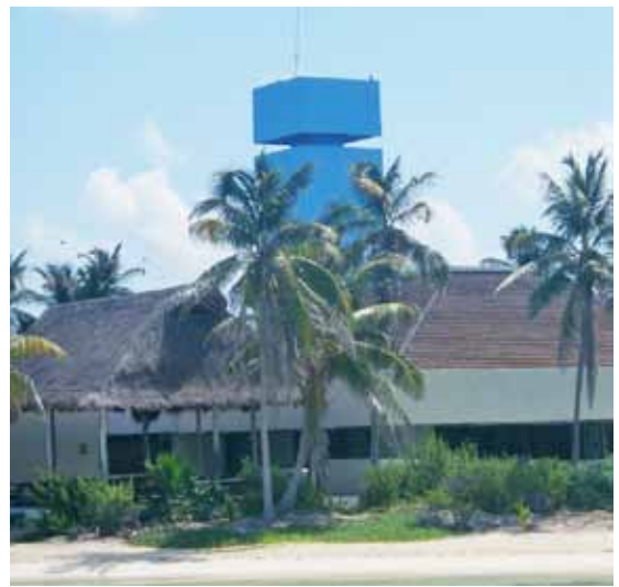
Vom Aussichtsturm auf Isla Contoy läßt sich die ganze Insel überblicken. Wegen der maroden Treppe ist der Zugang allerdings noch gesperrt.
