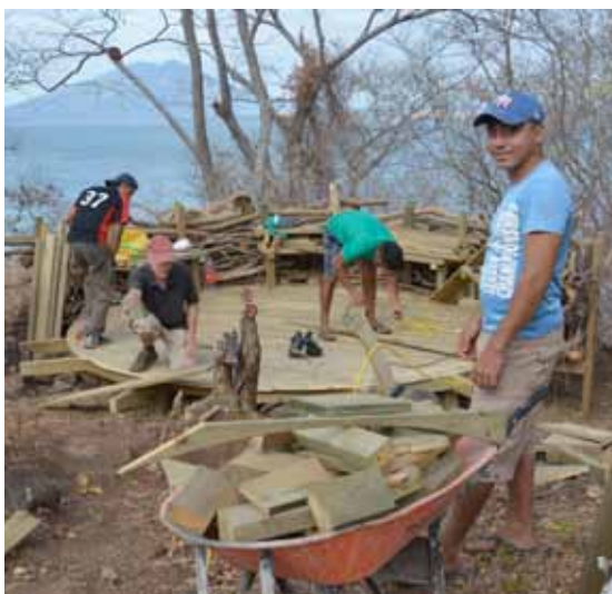
Die Bauten wurden durch ein Team aus einem deutschen Mitarbeiter und honduranischen Kollegen errichtet.
