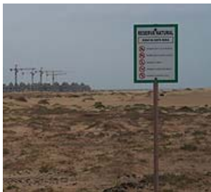
Naturschutz, Tourismus oder beides? Bau einer Ferienanlage unmittelbar an einem Naturschutzgebiet auf der Insel Sal.
