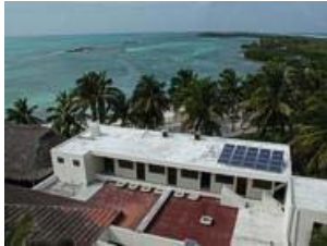
Blick vom Aussichtsturm des Besucherzentrums
