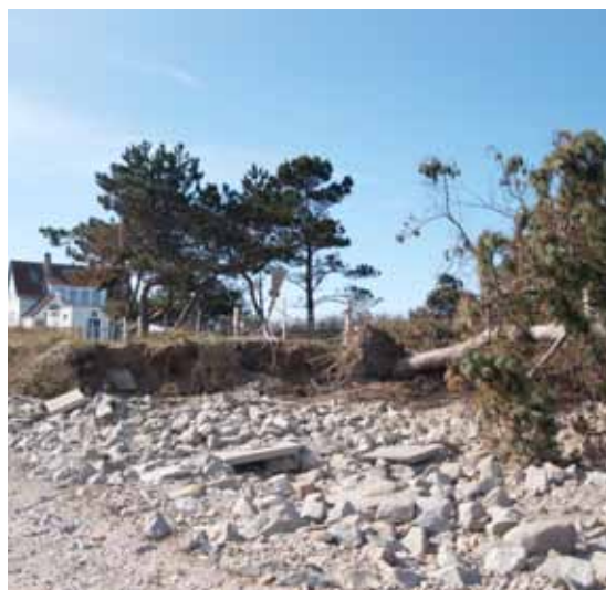
Die Wellen haben den Wurzelraum der Vegetation freigespült und Bäume und Sträucher entwurzelt.
