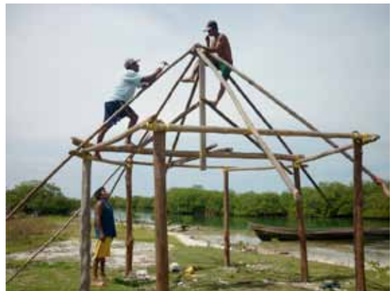
Bau des neuen Besucherzentrums in Dainyaa
